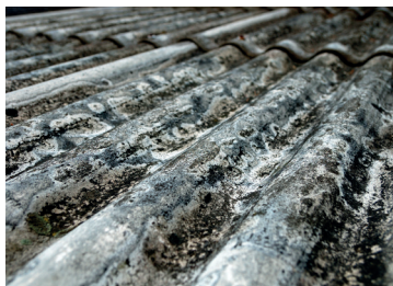
► Toiture en fibrociment
